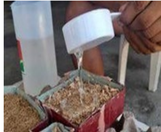
Fig.7. Pouring the epoxy resin
